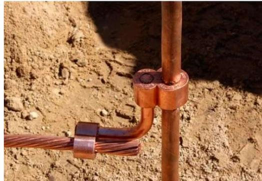
Use un sistema de conexión de varilla que no sufra oxidación.
